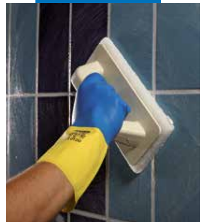
Anemulgieren von Kerapoxy CQ mit Wasser und einem Scotch-Brite®-Pad
